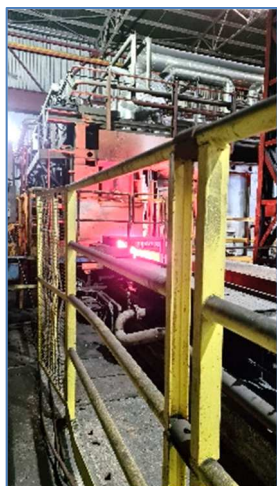
Forno di riscaldamento TS
