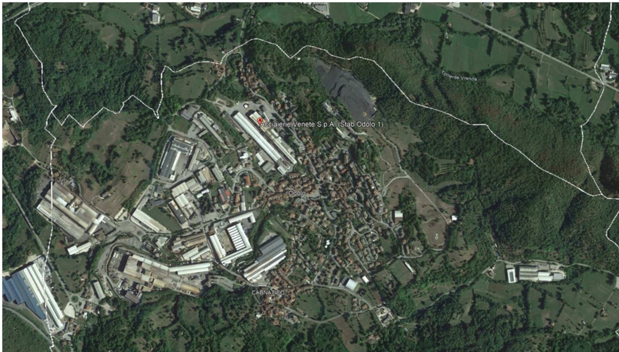
Figura 3.3.1. Posizione, su ortofoto, del sito Acciaierie Venete S.p.A. di Odolo (BS), Via Garibaldi n. 8
